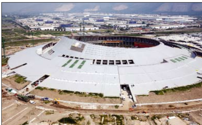
Prodajni center Vulcano v Italiji prekrit z membrano Sintofoil
